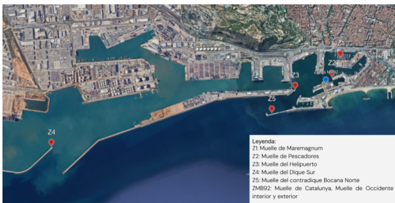
Figura 4. Vista aérea del Port de Barcelona, epicentro del programa de regeneración ambiental RegenPorts.
